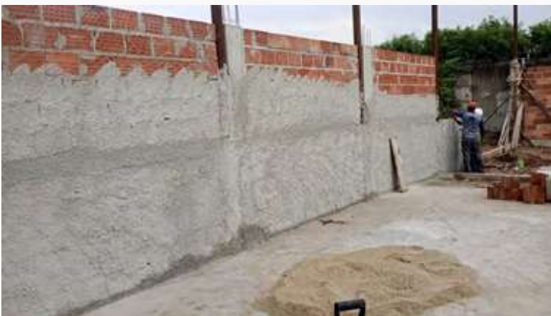
Obra de ampliação do galpão
