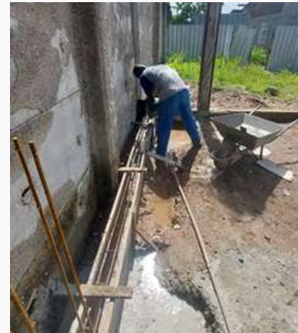
Obra de ampliação do galpão
