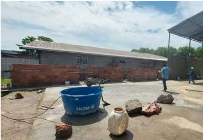
Obra de ampliação do galpão
